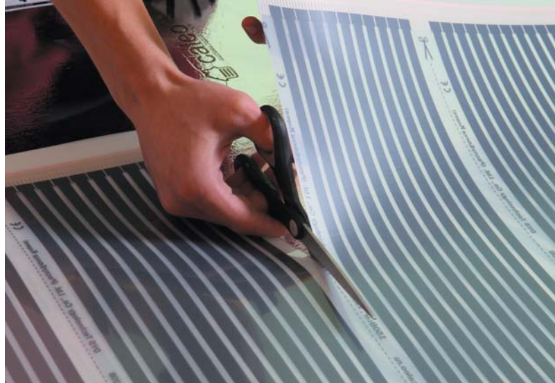
Рис. 5. Разрезание термопленки CALEO по линиям отреза
