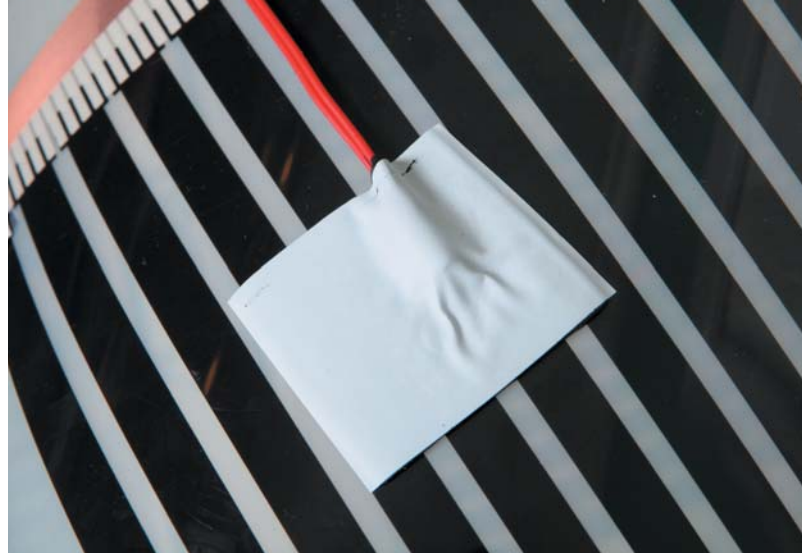
Рис. 24. Установленный и приклеенный датчик температуры пола. Вид снизу термопленки
