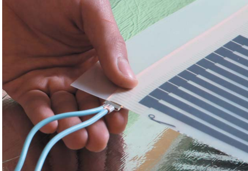
Рис. 14. Соединение монтажных проводов с контактным зажимом
